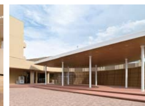
エントランスステージの新設
